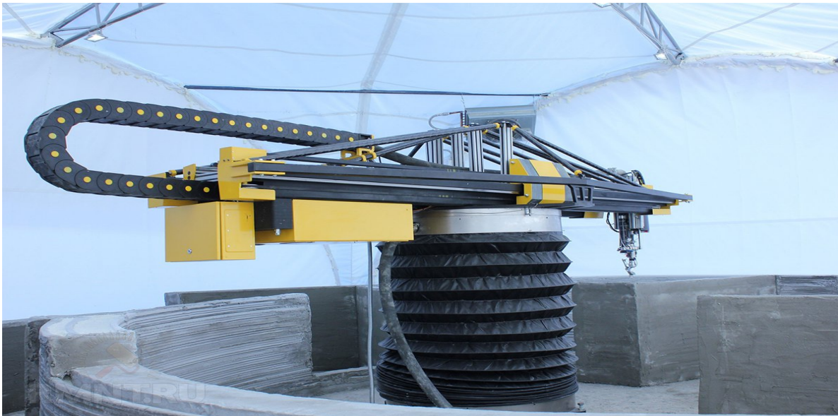
Рисунок 1. 3D-принтер для будівництва
