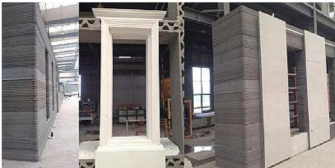
Рисунок 2. Зведення каркас будівлі
