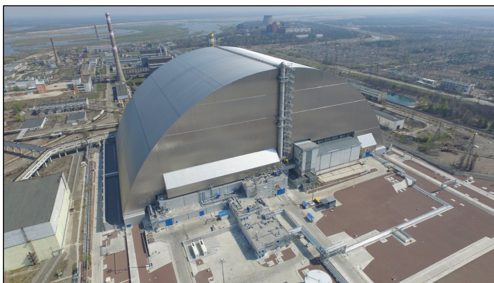
Рисунок 1 - Загальний вигляд комплексу нового безпечного конфайменту Чорнобильської АЕС
