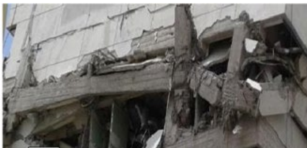
Рисунок 3. Приклади невдалих палпроектів, що призвело до руйнування будівель при впливі сейсмічних навантажень [8]
