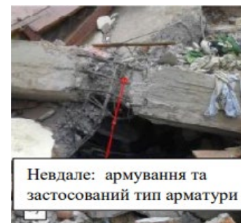
Рисунок 3. Приклади невдалих палпроектів, що призвело до руйнування будівель при впливі сейсмічних навантажень [8]
