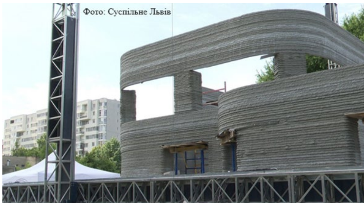
Рисунок 2 - Стіни початкової школи у м. Львів, зведені за допомогою технології 3D-друкованого будівництва у 2023р.
