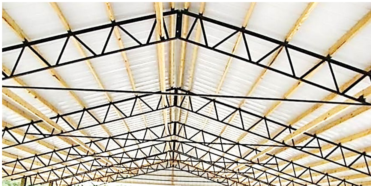
Рисунок – 4 Двосхилі ферми з паралельним поясами [7]:
