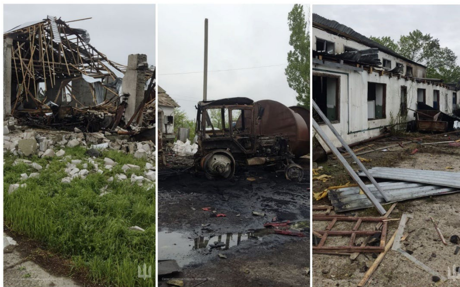
Рисунок 2 – Зруйновані виробничі будівлі та техніка фермерського господарства на Одещині внаслідок влучання ворожих дронів-камікадзе 22.04.2024
